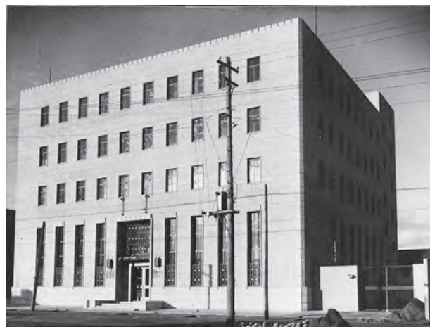
竣工した群馬大同銀行本店（昭和27年2月）
