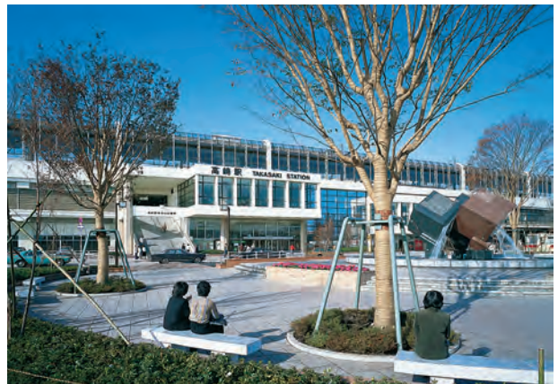
昭和57年3月に生まれ変わった高崎駅東口
