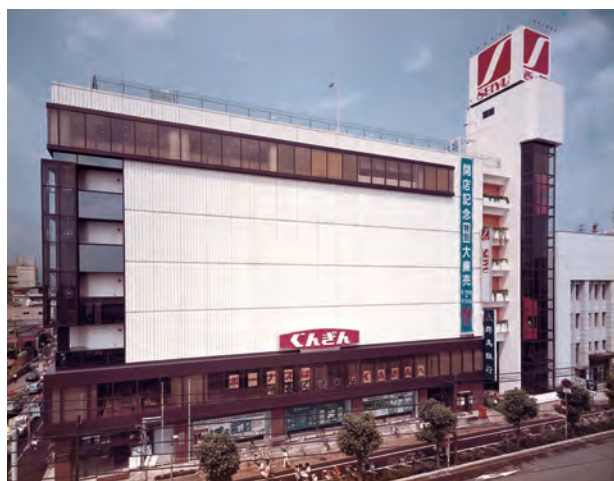
スーパーとの同居店舗となった前橋支店
