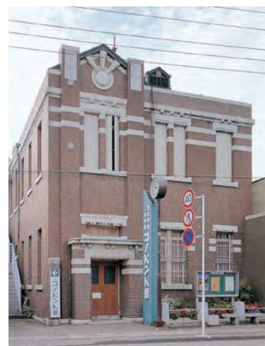
大正10年に建築された大間々銀行本店のレンガ造りの洋風建物は当行大間々支店に引き継がれたのち、現在はみどり市大間々博物館（コノドン館）として活用されている。 『颯爽たる上州』より
