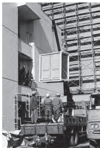
電算棟へコンピューターを搬入
