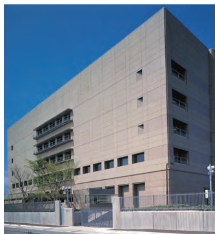
平成4年2月に完成した新電算棟
