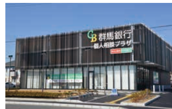
プラザ前橋（前橋南モール出張所）
