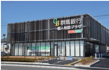
プラザ前橋（前橋南モール出張所）
