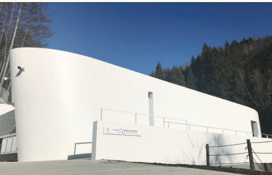
ぐんざん尾瀬片品発電所
