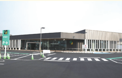
倉賀野支店外観
